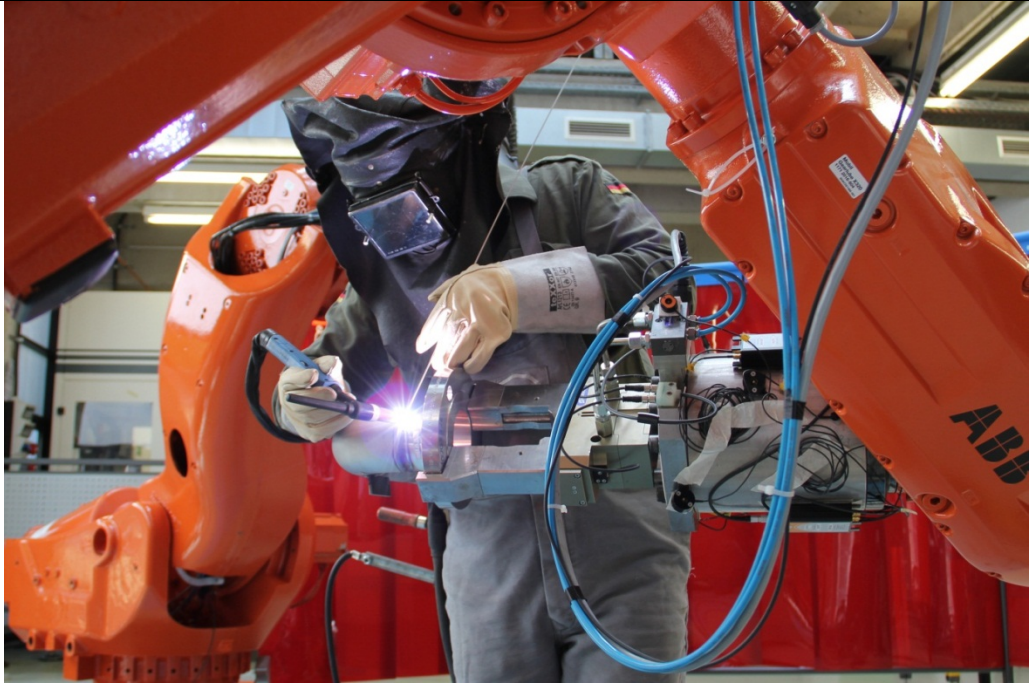
Abb. 4.1: Verschweißen einer Rohrverbindung im Roboterassistenzsystem rorarob (TU Dortmund)
